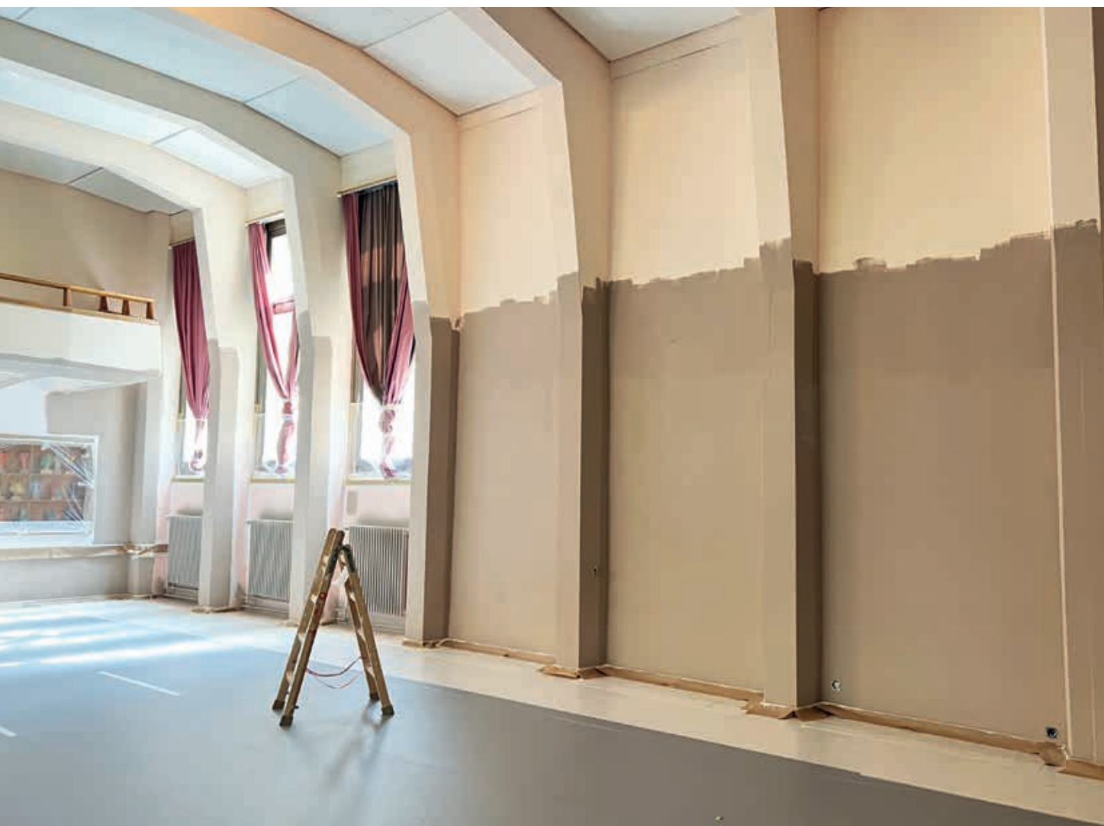
Die meisten Bilder in diesem Bericht zeigen die Renovation des Bühnensaals der Schulen an der Plattenstrasse
