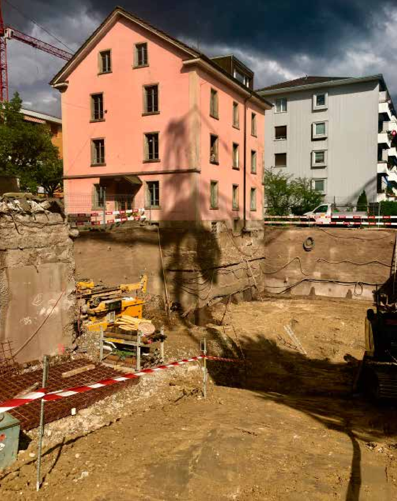
Baugrube Rudolf Steiner Schule Winterthur, Maienstrasse
